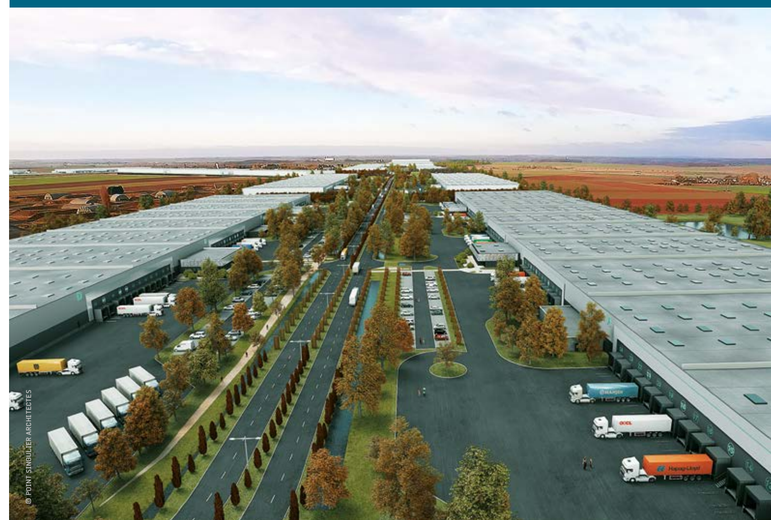
E-VALLEY | Lieu : CAMBRAI (59) | La plus grande base e-logistique d'Europe | 700 000 m 2 d'entrepôts pour le compte de Brookfield | Architectes : POINT SINGULIER ARCHITECTES | Livraison : En cours
